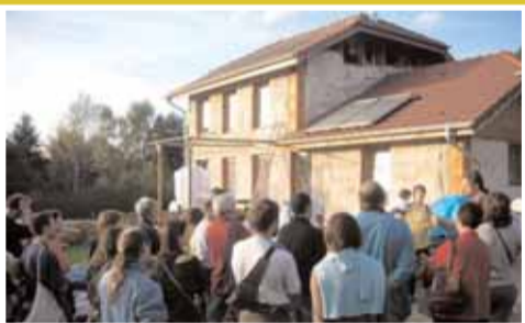
Visite d'une maison de paille par des particuliers organisée par l'EIE de St Dié.
