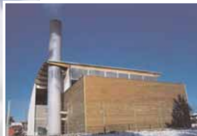
Chaufferie bois de la Colombière à Epinal.
