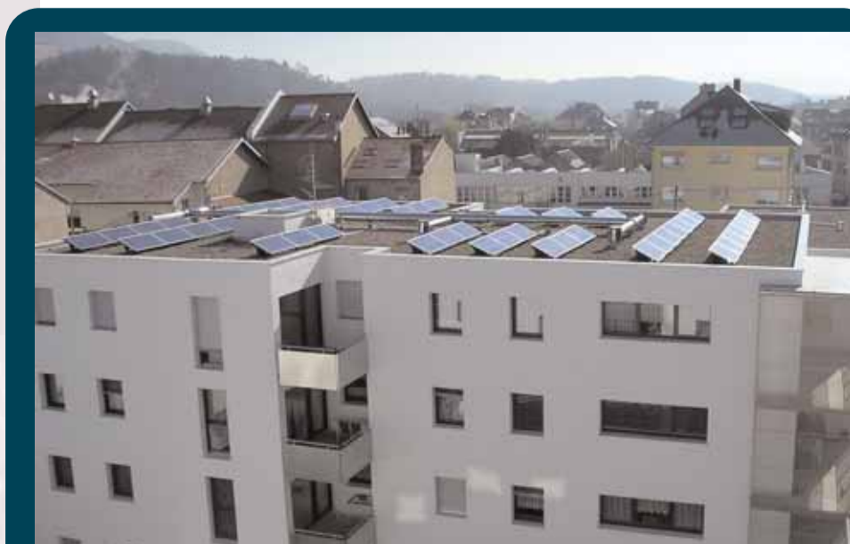
Construction de logements sociaux intégrant le solaire photovoltaïque en toiture.
